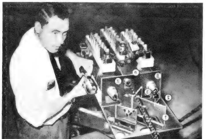
Bild 8. RCA-Farbkamera (Abdeckhaube entfernt). ---= blaue Strahlen passieren den dichromatischen Rotspiegel (1) und werden über den dichromatischen Blauspiegel (3) und Normalspiegel (2) zur Linse (5) reflektiert. ...= grüne Strahlen passieren (1) und (3) und laufen direkt zur Linse (6) ---= rote Strahlen werden durch Rotspiegel (1) und Normalspiegel (4) zur Linse (7) reflektiert. Hinter jeder Linse befindet sich eine Image-Orthikonröhre
