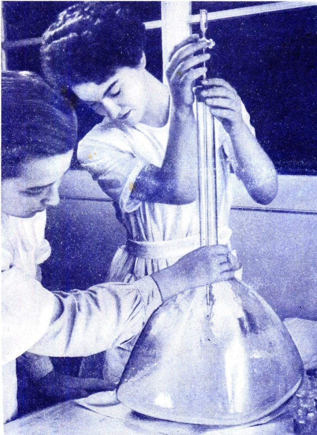
Eine beinahe heilige Handlung stellt das Auftropfen der Kollodium-Lösung auf die Wasseroberfläche im Bildröhrenkolben dar. Es ist dies einer der wichtigsten Arbeitsvorgänge bei der Herstellung metallisierter Bildröhren. (Aufnahme aus der Röhrenfabrik der Loewe-Opta AG: E. Schwahn)
